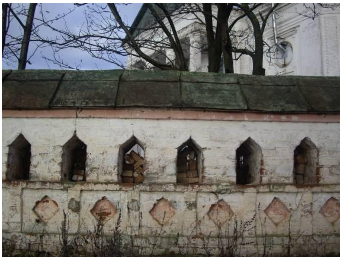
Кирпичная ограда церкви.
