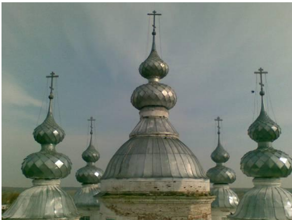
Купола храма были покрыты оцинкованным железом в 2002 году.
